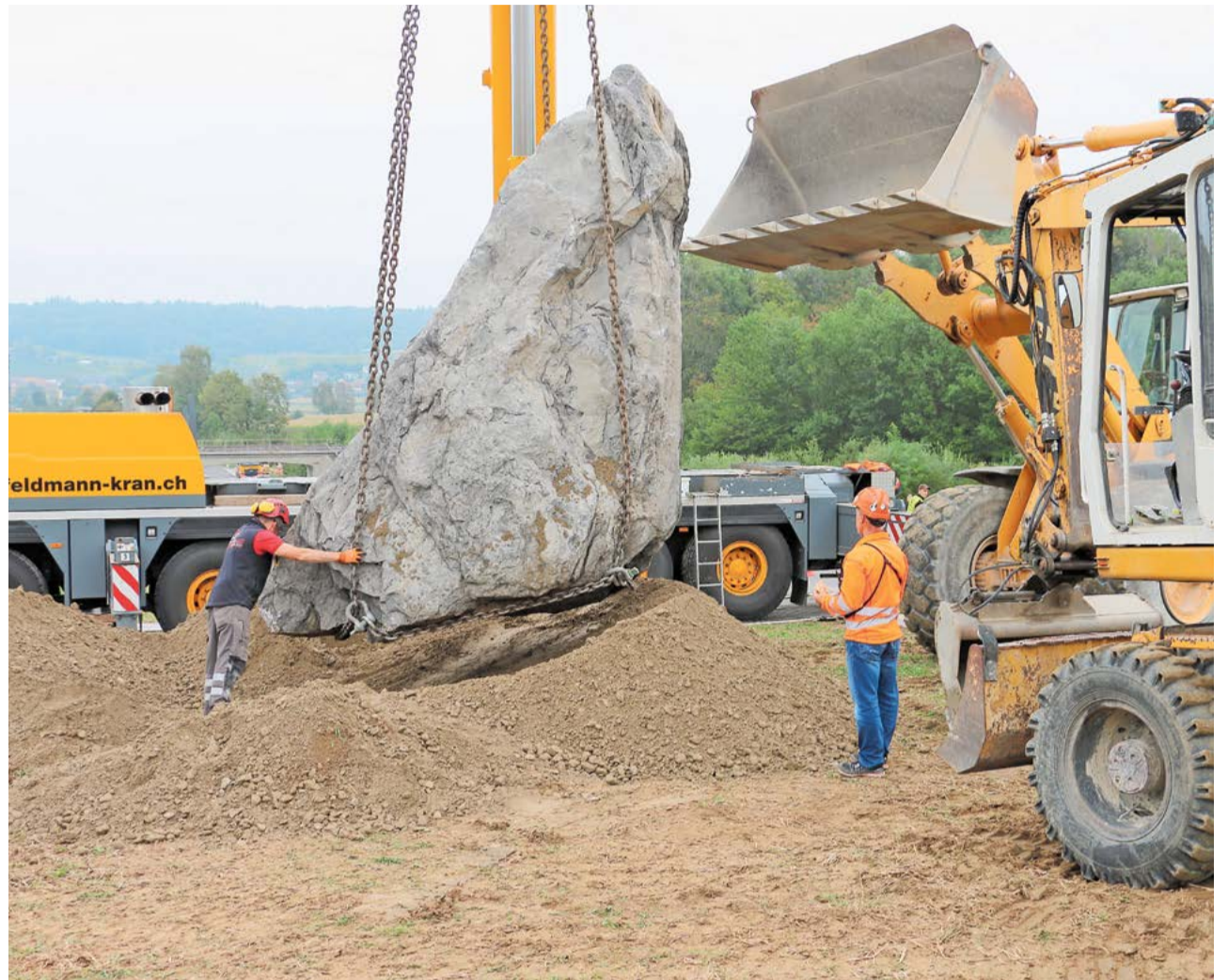
Mit schwerem Gerät wird der Hinkelstein platziert.
